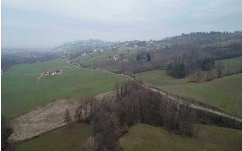
Figura 7.11 Area di imbocco della galleria naturale: versanti medio – collinari coltivati
