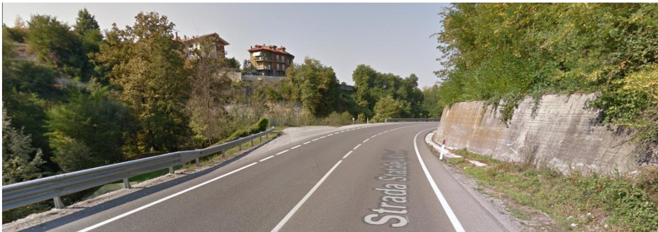
Figura 6.13 Viadotto Ermeno: intervistibilità limitata all'area strettamente adiacente l'intervento
