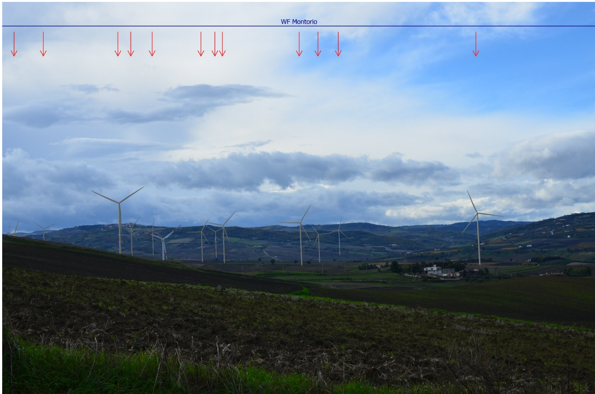
Foto 8b: Punto di ripresa fotografica (P2) 41.819645° 15.002383° (strada di accesso al Comune di Ururi) - vista panoramica area d'impianto – POST OPERAM
