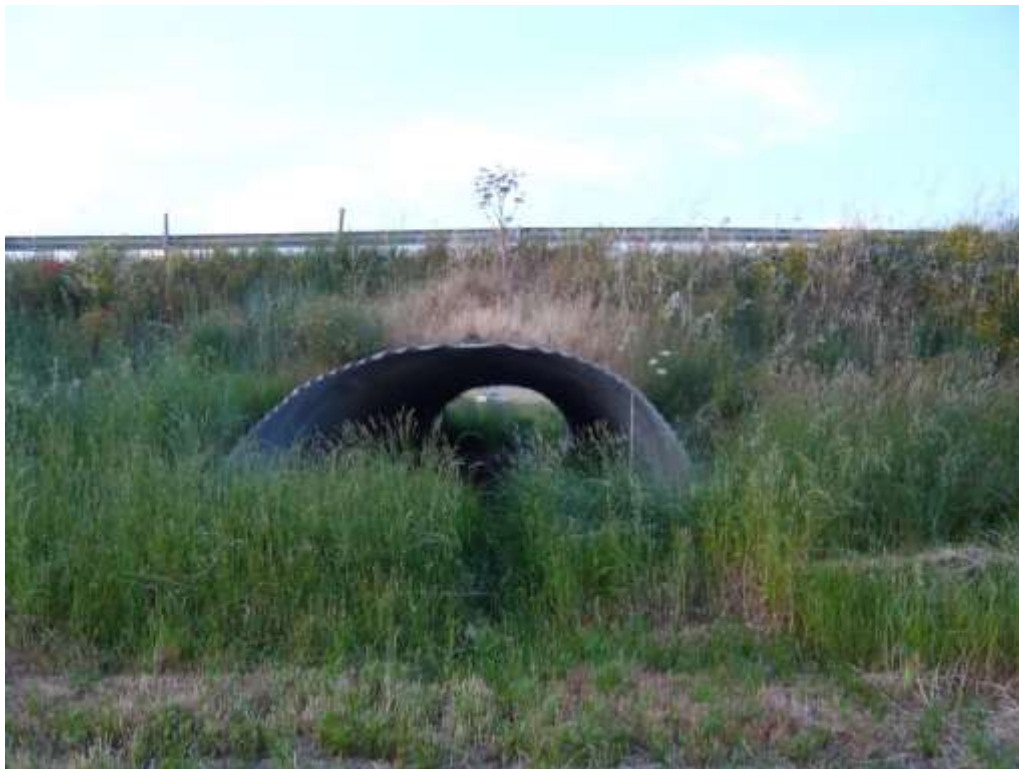
Foto 6.7 – Vista del tombino di attraversamento della SP 140, nei pressi della sezione 64 del Reticolo E .
