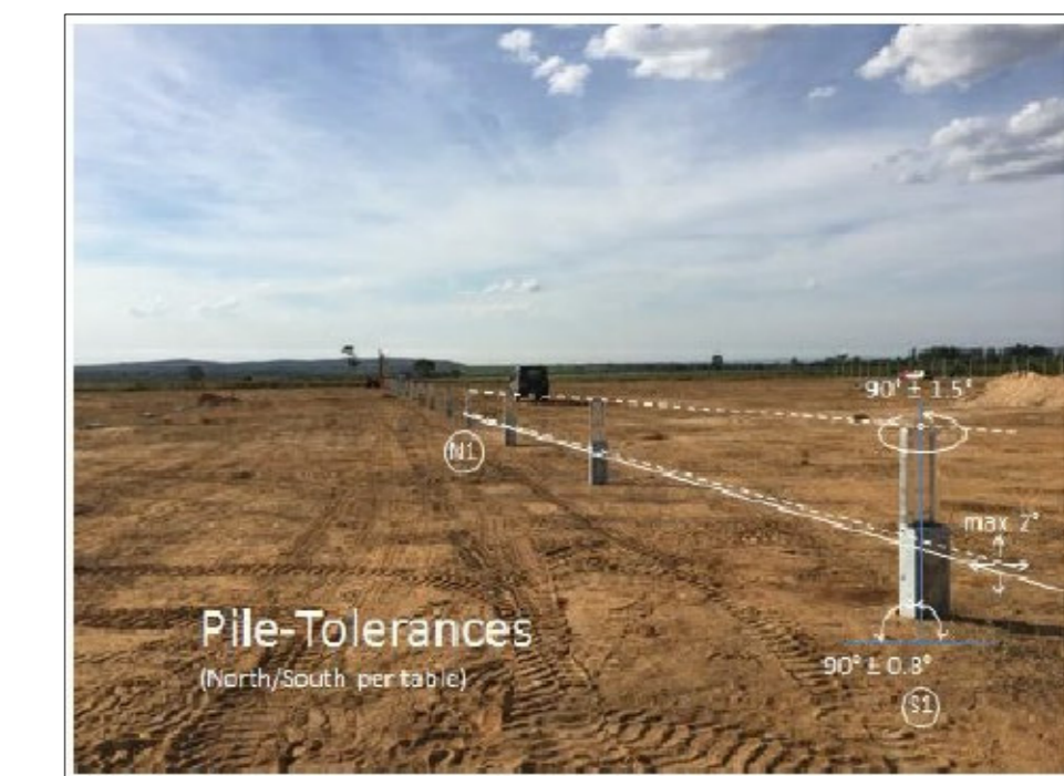
Allineamento Pali infissione
