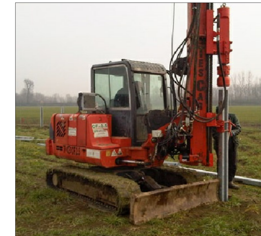
Macchina Batti-Pali Infissione pali profilati
