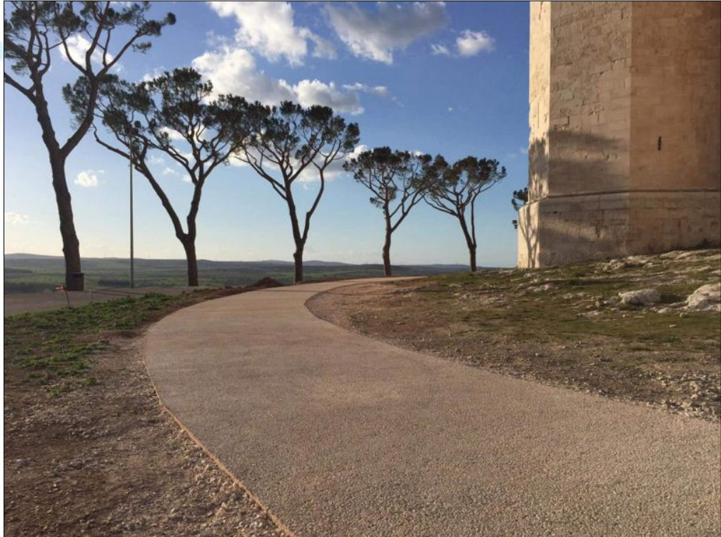
Immagine esemplificativa di una strada in terra stabilizzata
