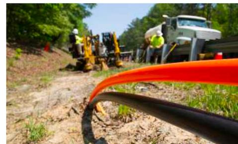
**CICLI DI PRODUZIONE IMPAREGGIABILI.** Il D40x55 S3 presenta una velocità del carrello di 57,3 m/min, registrando un aumento del 7% rispetto al suo predecessore (il D36x50 Serie II) e permettendo così di coprire maggiori lunghezze lineari al giorno.
