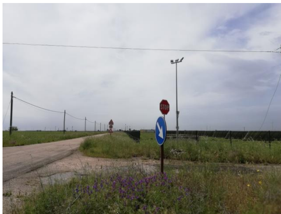
DA RILIEVO SUL CAMPO: IMPIANTO FOTOVOLTAICO CARTA USO DEL SUOLO (AGG. 2012): SEMINATIVO
