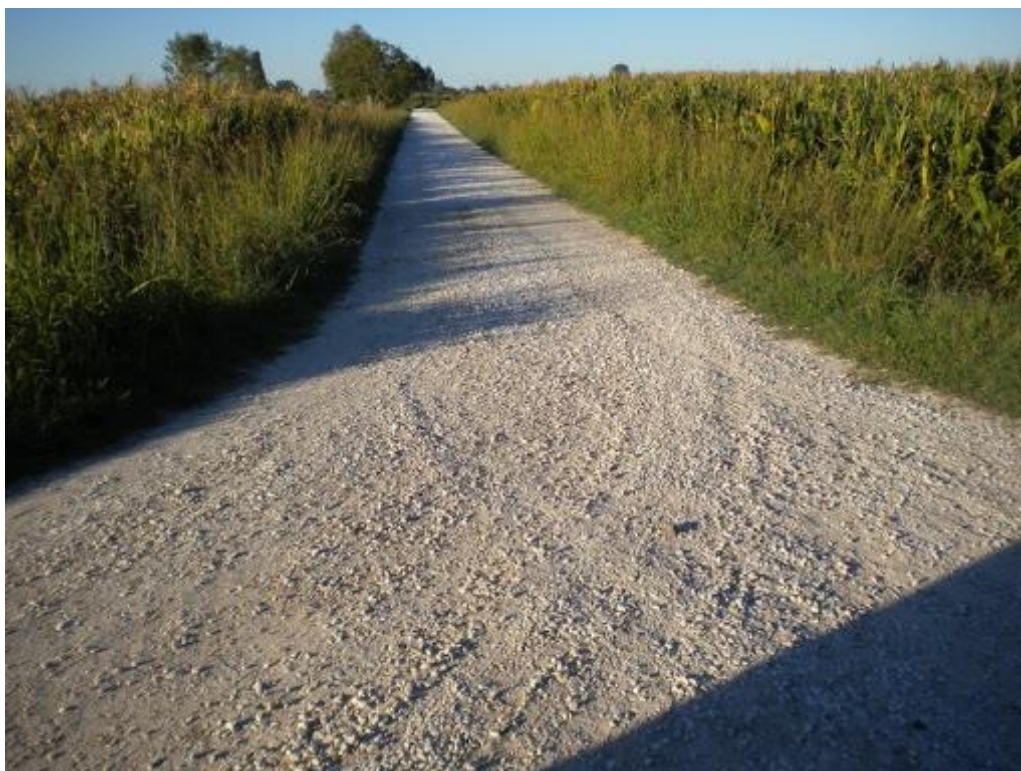
Figura 14: strada interna tipo MacAdam del progetto Sicilia
