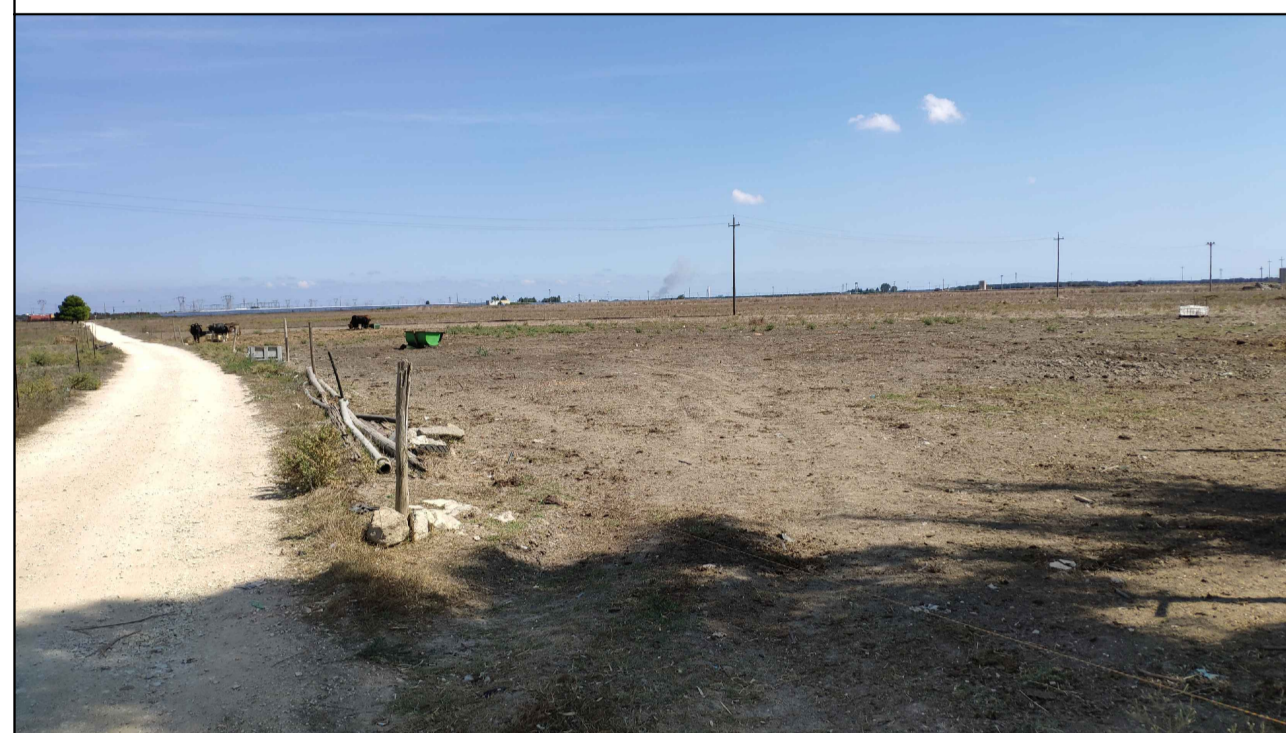
F3 - AREA IMPIANTO AGROVOLTAICO
