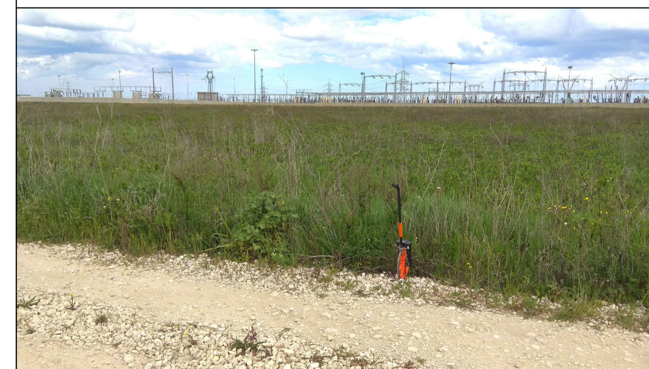
F4 - AREA STAZIONE ELEVAZIONE
