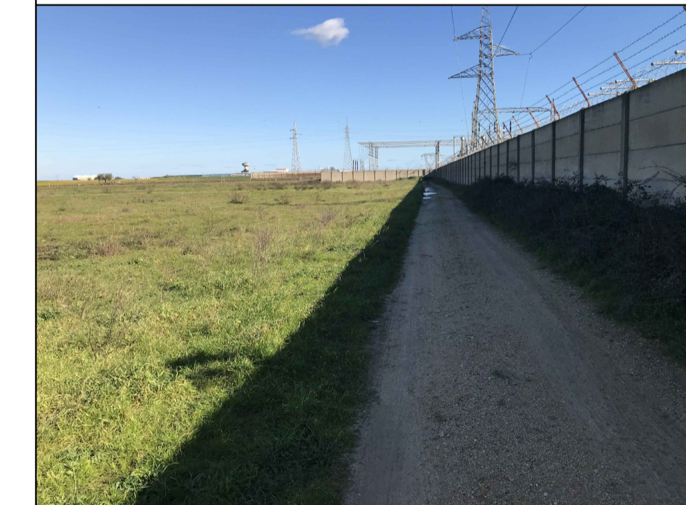
F12 - AREA STAZIONE ELEVAZIONE
