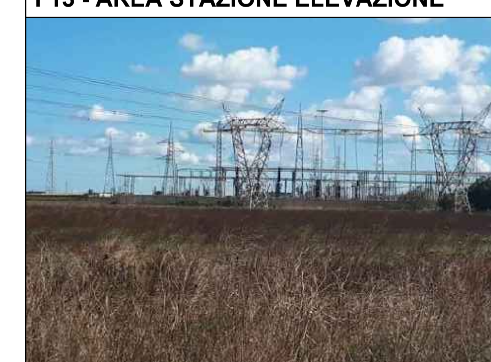
F13 - AREA STAZIONE ELEVAZIONE
