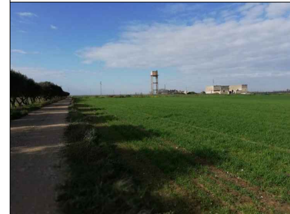
F4 - AREA IMPIANTO AGROVOLTAICO
