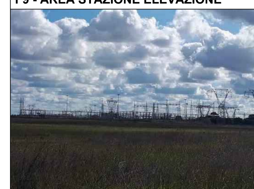
F9 - AREA STAZIONE ELEVAZIONE
