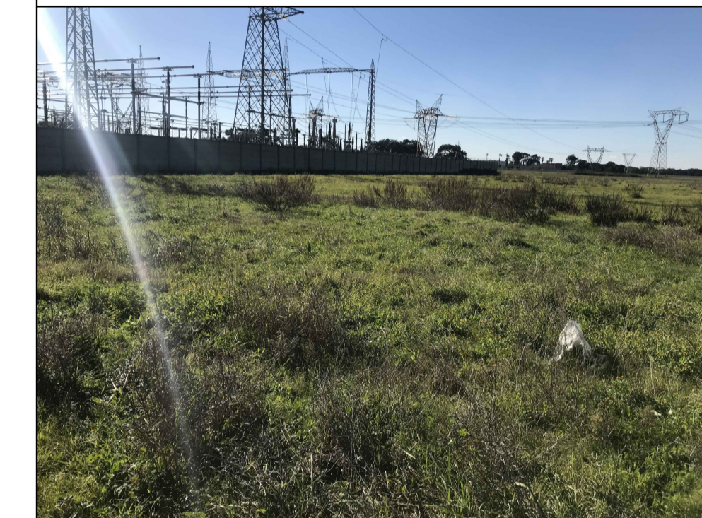
F11 - AREA STAZIONE ELEVAZIONE
