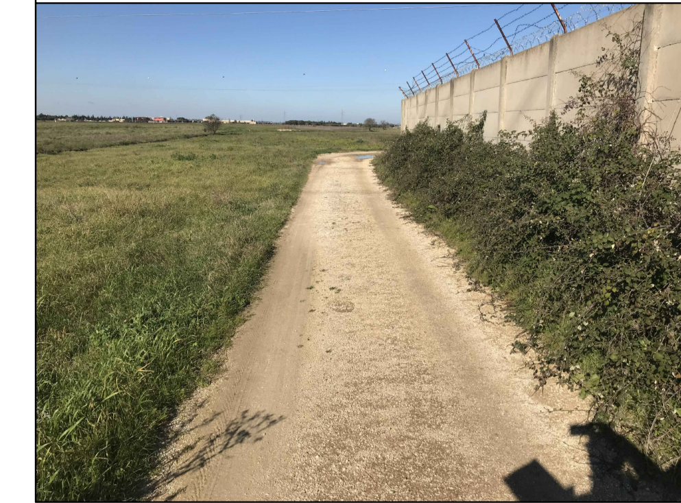
F10 - AREA STAZIONE ELEVAZIONE
