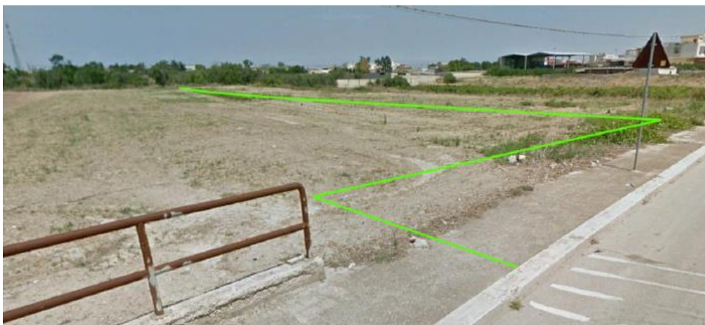
Figura 8 – Innesco pista di cantiere
