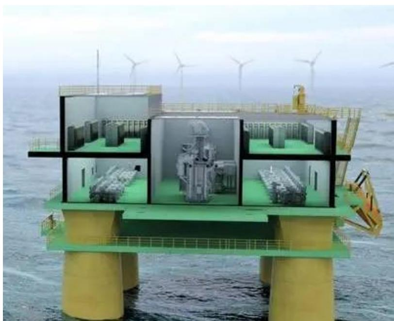
Figure 27/28/29 – Esempio di Stazione HVDC di trasformazione 150/500 kV.
