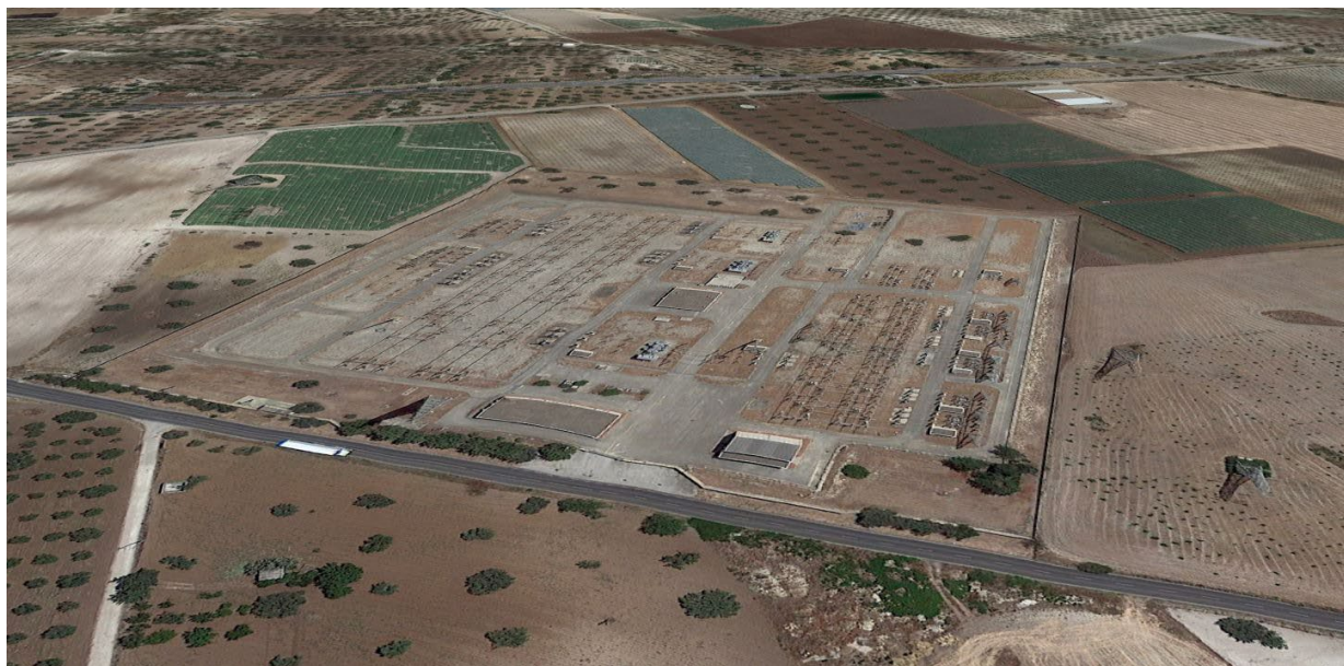
Fig. 11 – Immagine della SSE 380 kV Chiamonte Gulfi di Terna.
