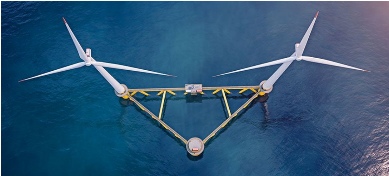
Figure 7/8 – Struttura di fondazione galleggiante con doppio aerogeneratore
