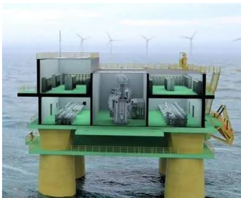
Figure 9/10/11 – Esempio di Stazione HVDC di trasformazione 150/500 kV.
