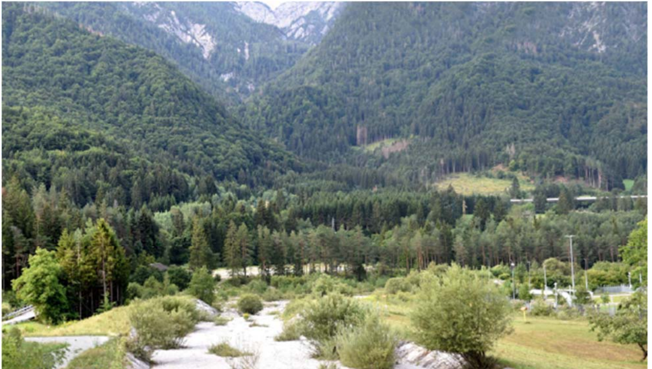
Figura 21 – PDV04 - Stato di fatto, lato Nord della futura SSE Utente e SE Terna
