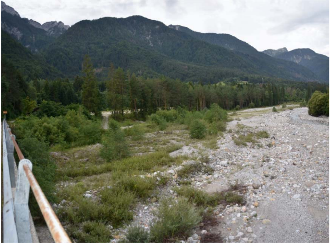
Figura 19 – PDV05 - Stato di fatto, lato Nord della futura SSE Utente e SE Terna
