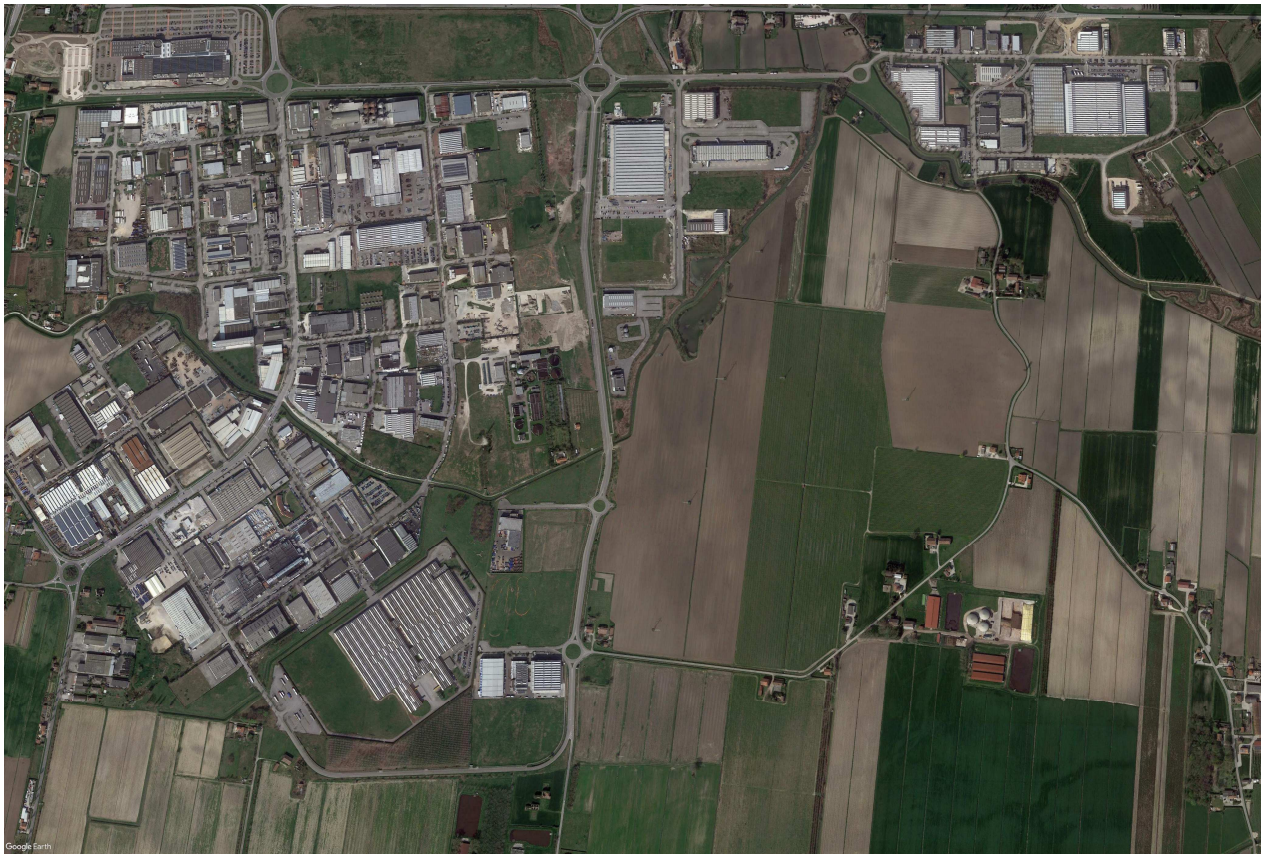
Figura 1 - Vista aerea stato attuale
