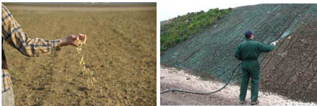
Figura 7 - Idrosemina e semina a spaglio
