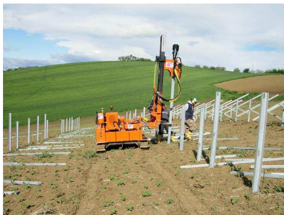
Figura 4 - Posa strutture metalliche di fondazione
