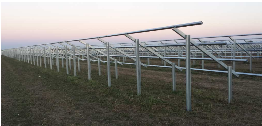
Figura 5 - Stato cantiere al termine della fase lavorativa
