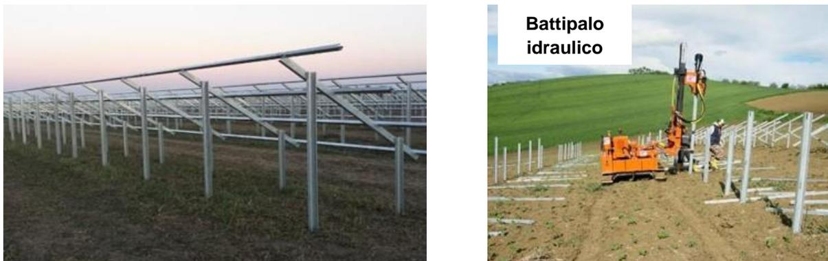
Figura 5-2 – Esempio di posa delle strutture portanti.
