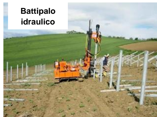
Figura 6-1 – Esempio di posa delle strutture portanti.
