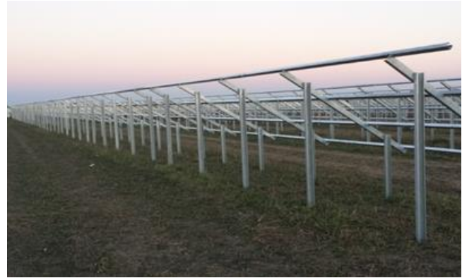
Figura 3-10 - Stato cantiere al termine della fase lavorativa
