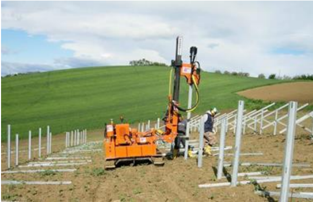
Figura 3-9 – Messa in opera delle strutture di sostegno
