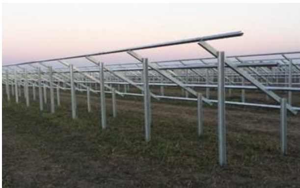
Figura 6-1 – Esempio di posa delle strutture portanti.
