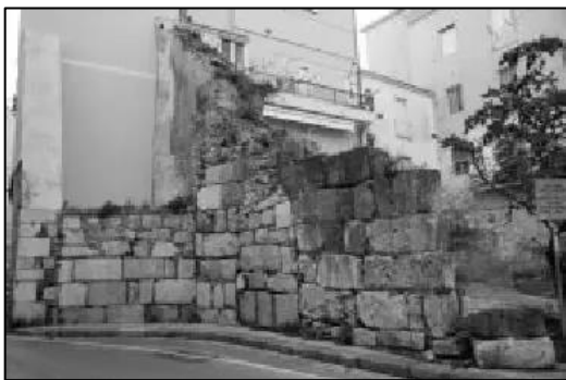
Fig 4 - Tratto di mura in via Docibile (da Caruso 2018, fig. 2, p. 85) 2 .
