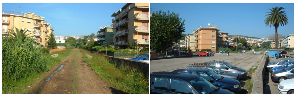
TRATTO IN DISUSO NEL COMUNE DI GAETA
