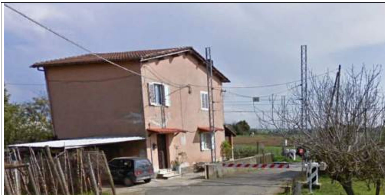
Vista Fabbricato km 29+514
