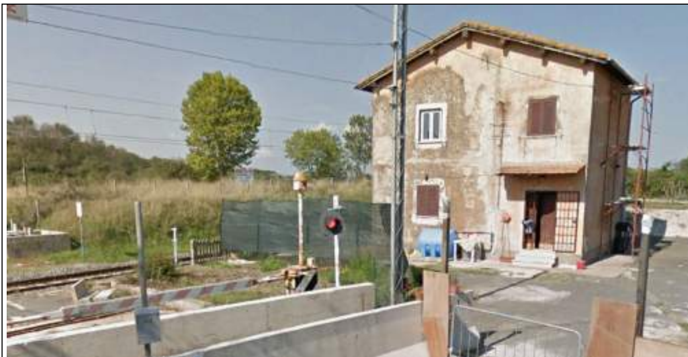
Vista Fabbricato km 38+153
