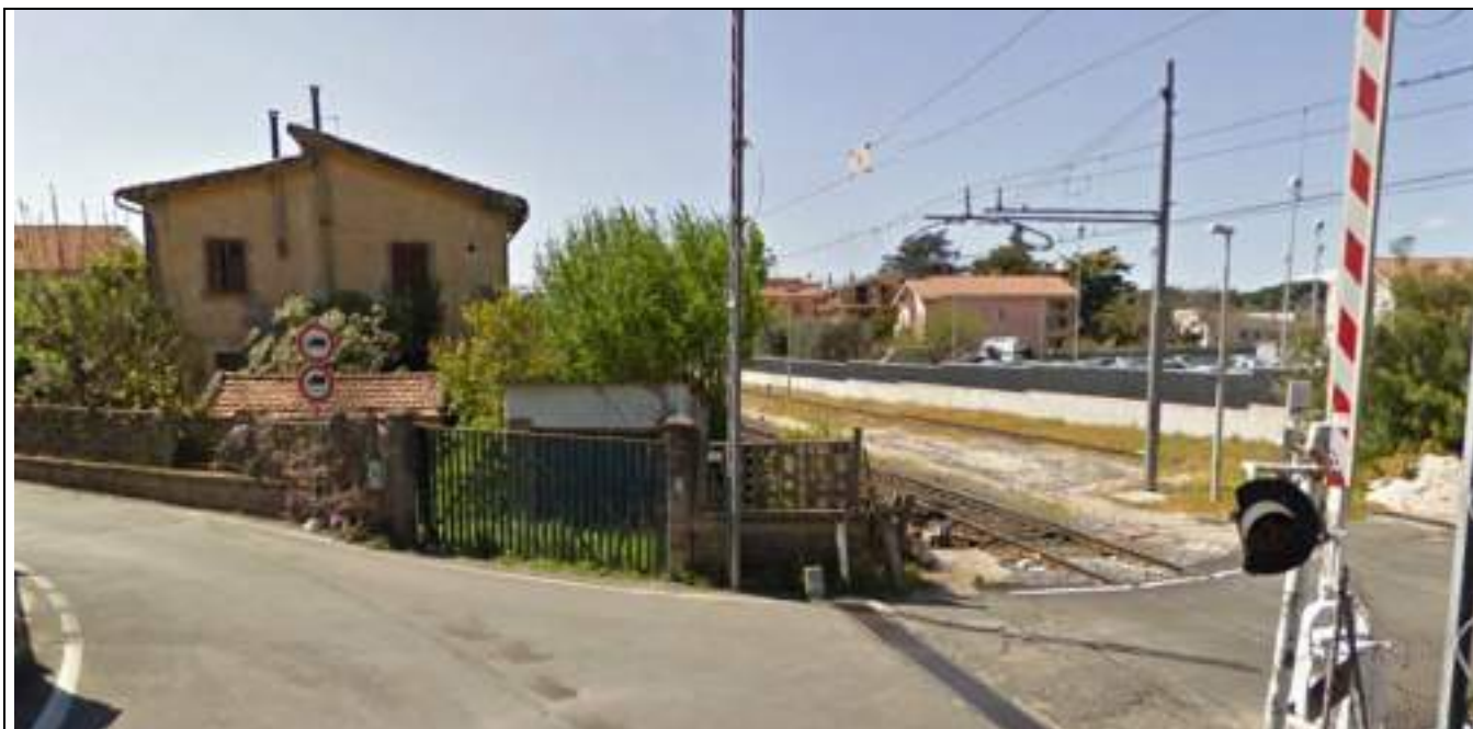
Vista Fabbricato km 30+376
