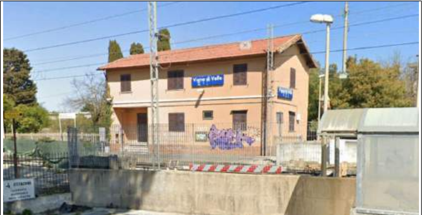
Vista Fabbricato viaggiatori km 39+235
