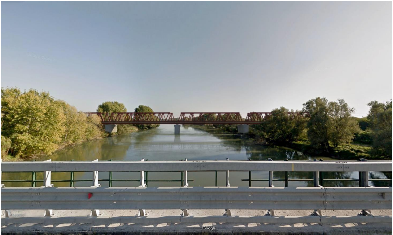
Figura 5 – Viadotto ferroviario sull’Oglio VI02. Condizioni percettive post operam
