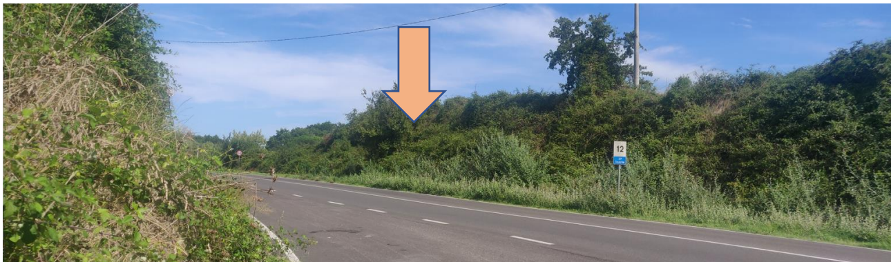
Figura 10 - PDV 3, Stato di fatto
