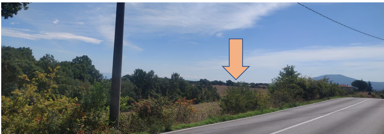
Figura 27 - PDV 9, Stato di fatto
