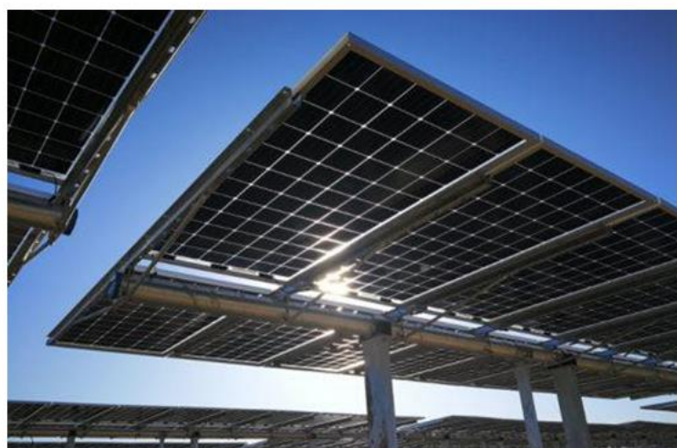
Figura 2.5: Particolare strutture di sostegno moduli
