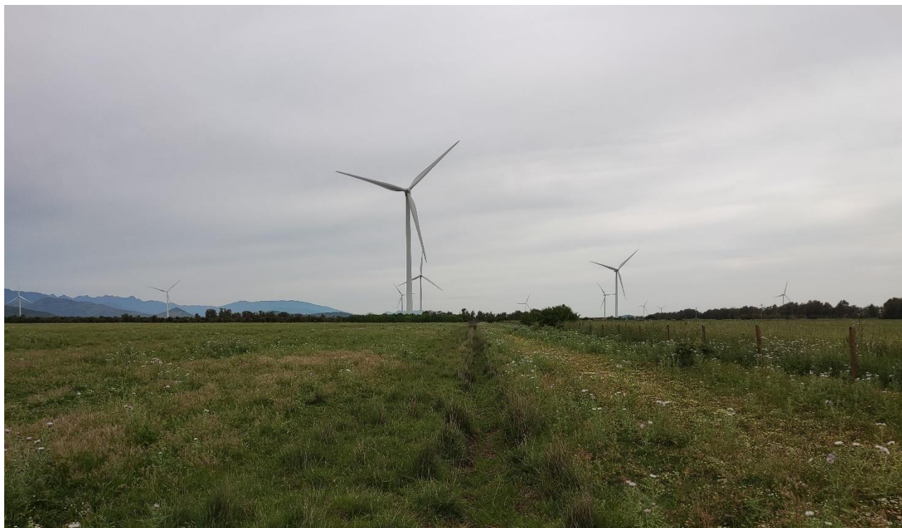
Figura 2.2: Panoramica sito d'impianto.
