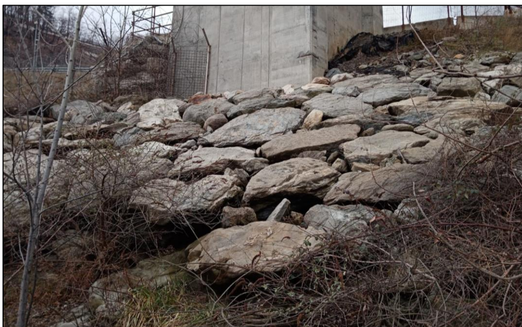
Figura 10 – Protezione PILA P10
