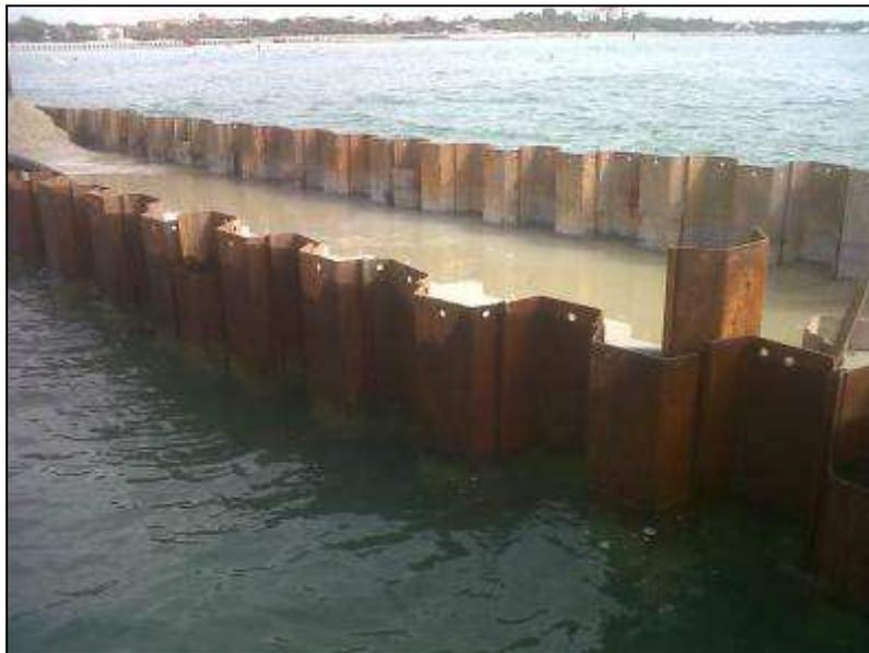
**Fig. 3.6.4: Postazione di recupero con palancole per il contenimento e il recupero dei fanghi di perforazione**
