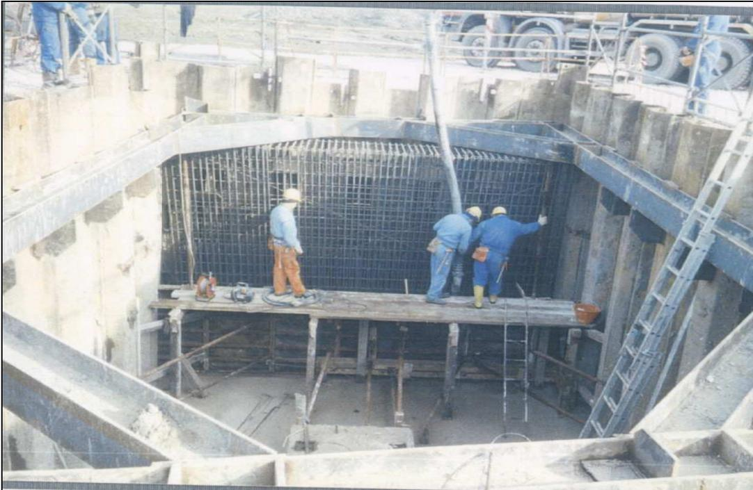
**Fig: 3.3.1: Postazione di trivellazione per microtunnel realizzata con palancolato metallico e getti in c.a., durante le fasi di costruzione.**
