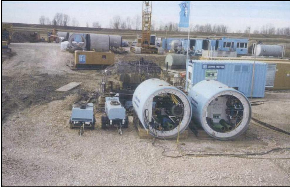
**Fig. 3.3.2: Tipico cantiere per la costruzione di un microtunnel.**
