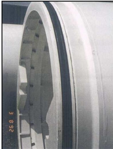
**Fig. 4.4.2: Conci tubolari in c.a. prefabbricati. Il giunto di tenuta idraulica è già installato.**
