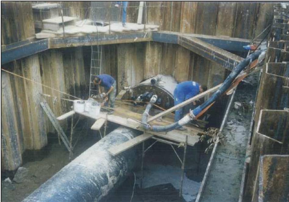
**Fig. 5.1.2: Intasamento del microtunnel con miscele cementizie dalla postazione di recupero (Attraversamento F. Po – Metanodotto Potenziamento Importazione da C.S.I.)**
