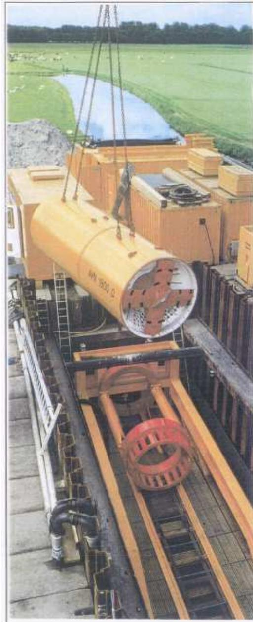
**Fig. 4.4.4: Predisposizione di una testa fresante nella postazione di trivellazione onshore**
