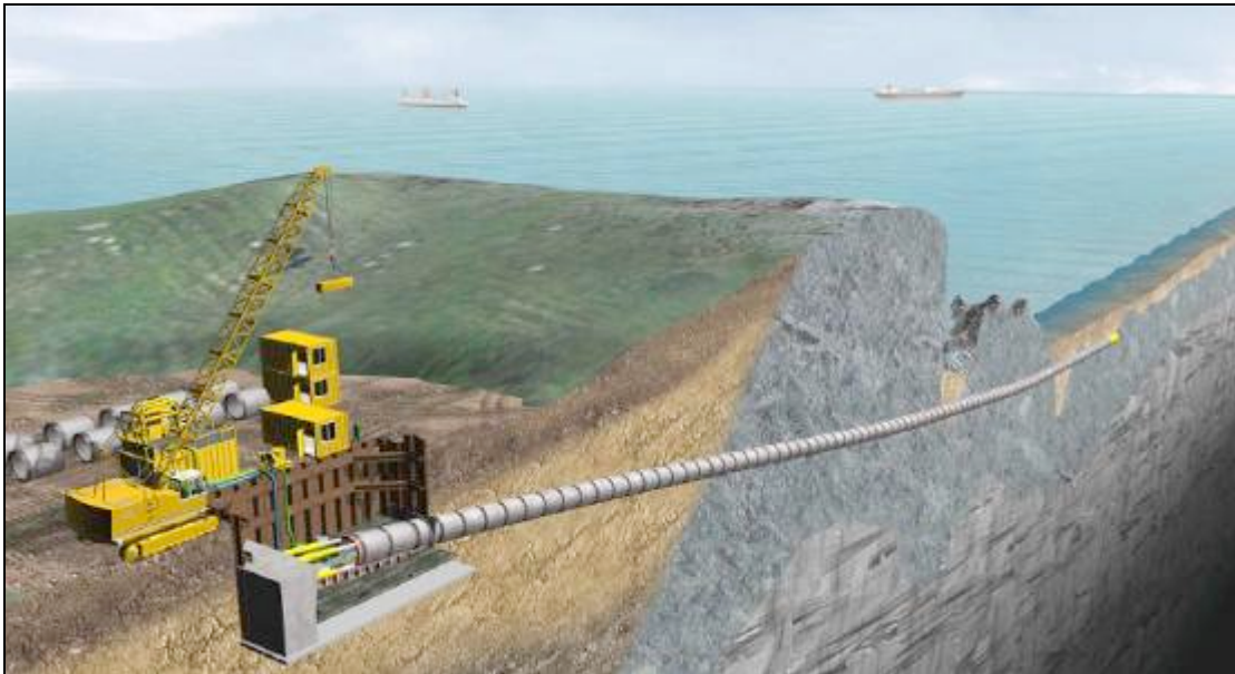
Fig. 3: Costruzione del microtunnel sottomarino (Estratto da: “ Trenchless installation methods of Sea Outfalls ”)
