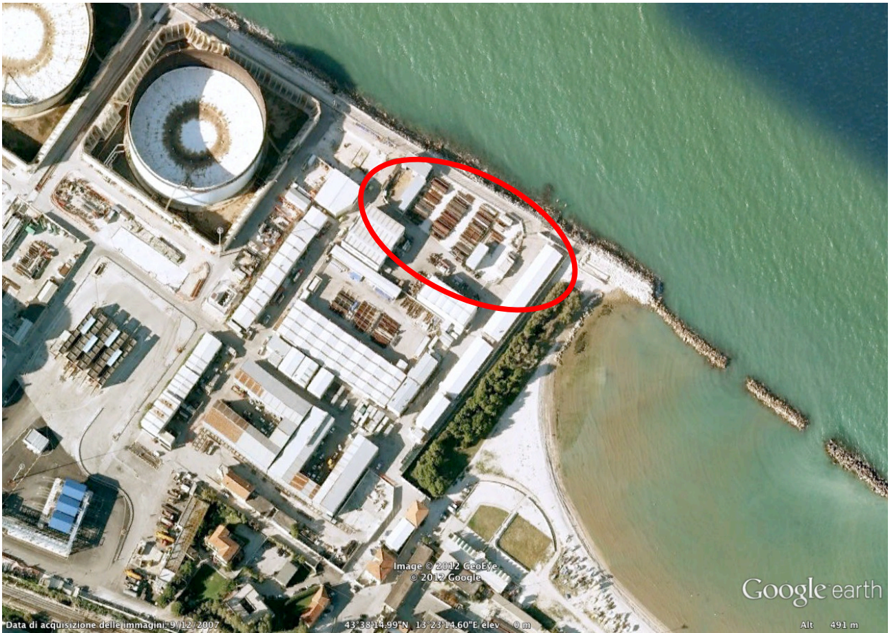
Fig. 2: Area del cantiere
