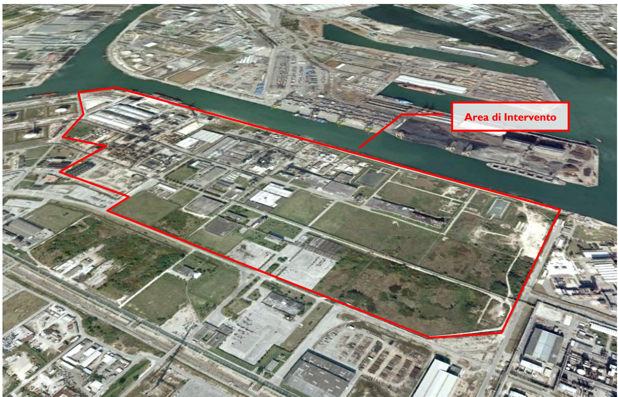
Figura 2.23. Vista dello stato attuale dell'Area di Intervento lato sud-est (fonte: Google Earth)
