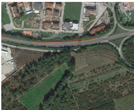
Barriera n. 02 e sulla sinistra (Ovest, direzione Caianello) un tratto della barriera n.01.
