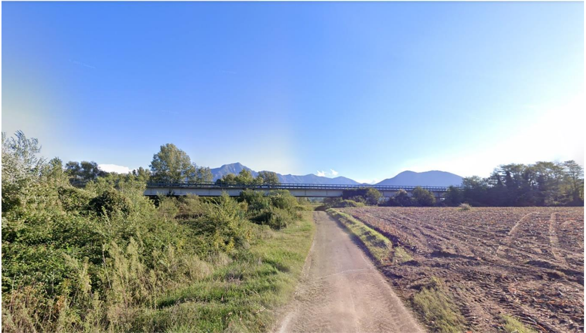
Viadotto sul fiume Titerno sulla sinistra in foto (direzione ovest), vista Ante operam .
