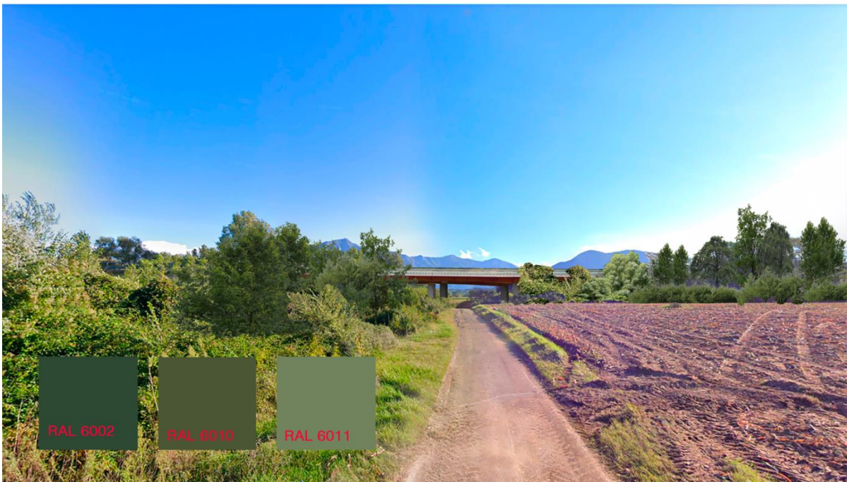
Viadotto sul fiume Titerno sulla sinistra in foto (direzione ovest), vista Post operam (compresi gli interventi di mitigazione ambientale) e cromatismi
