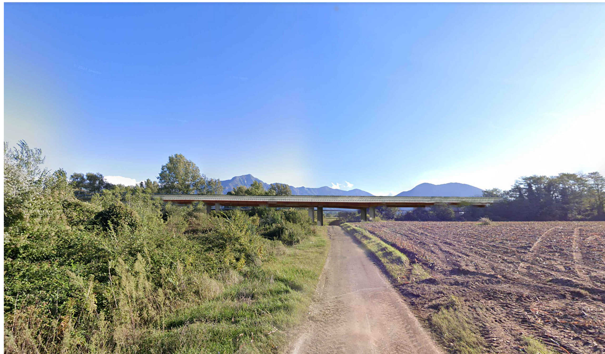
Viadotto Titerno - Vista 1 - Post operam
