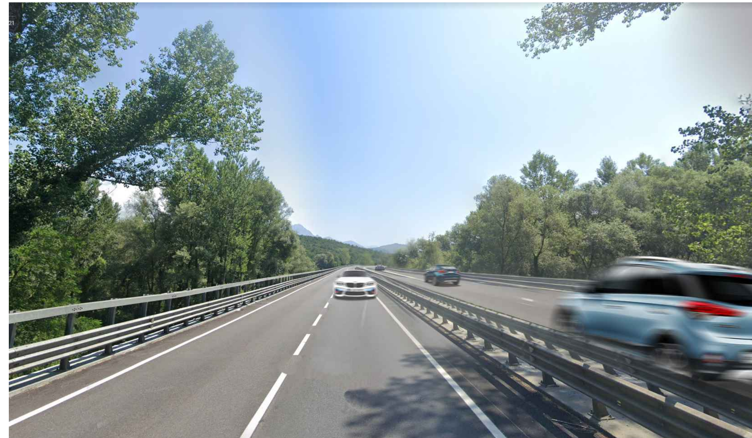
Viadotto Volturmo - Vista 2 - Post operam
