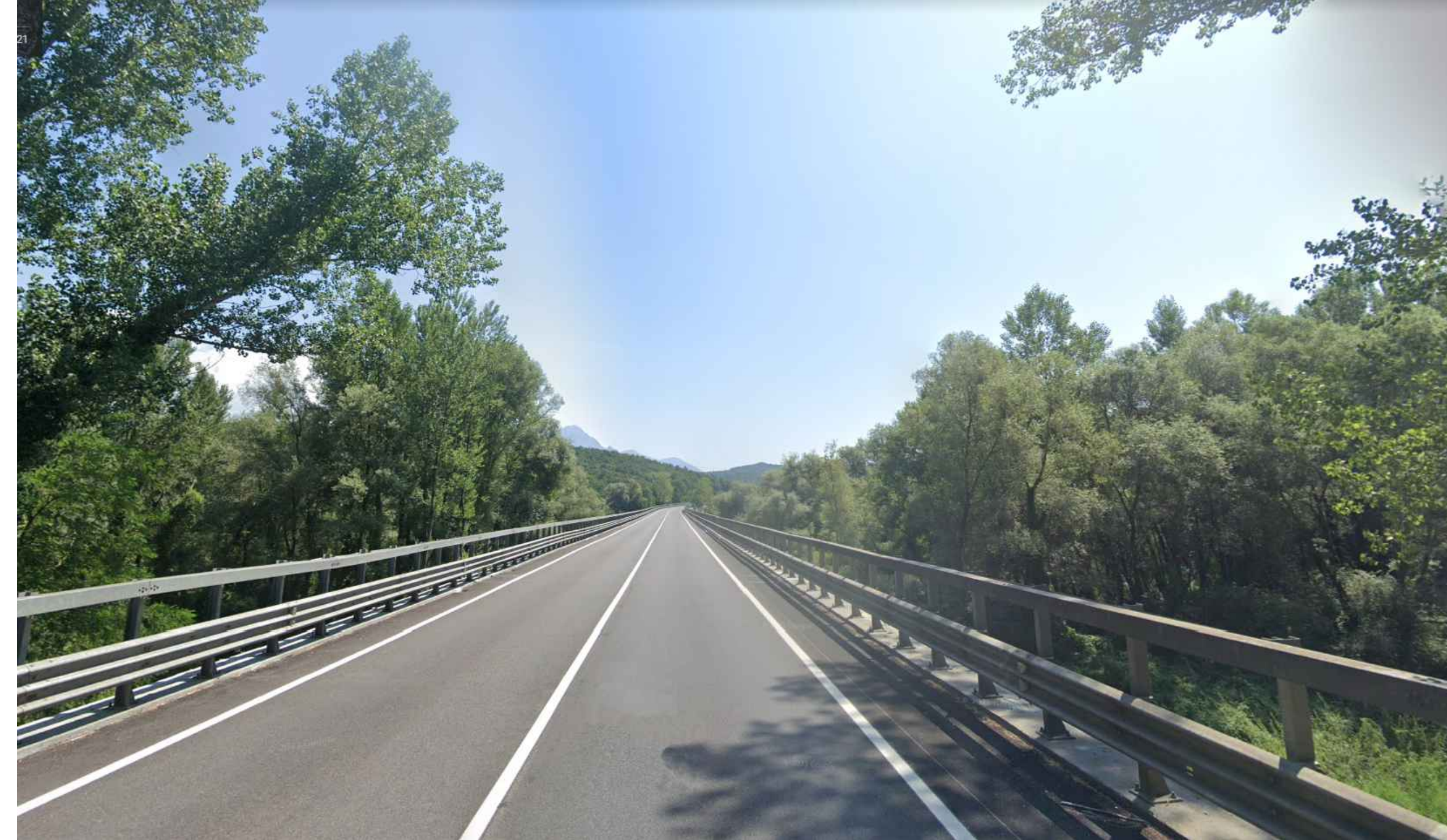
Viadotto Volturmo - Vista 2 - Ante operam
