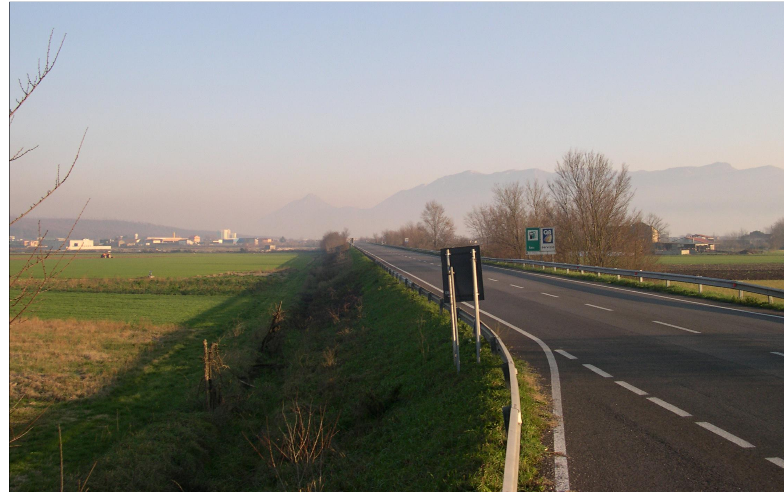
Svincolo Faicchio - Vista 4 - Ante operam
