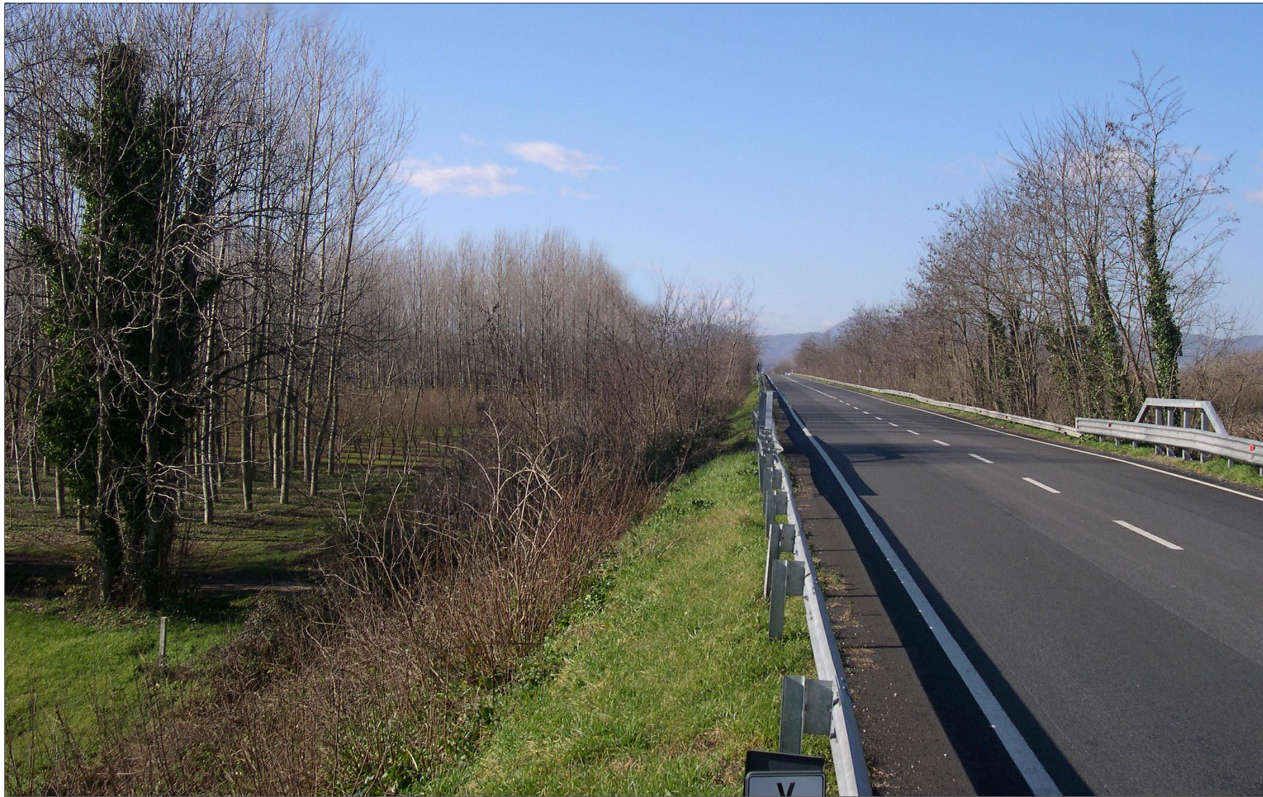
Svincolo Pietravairano - Vista 3 - Ante operam
