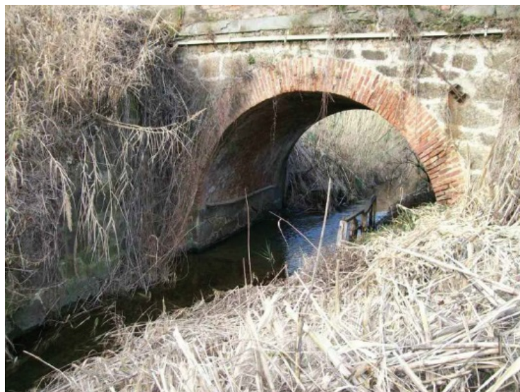
Figura 9.6 – Ponte esistente sul Rio Lusso – Ponte ad arco in muratura
