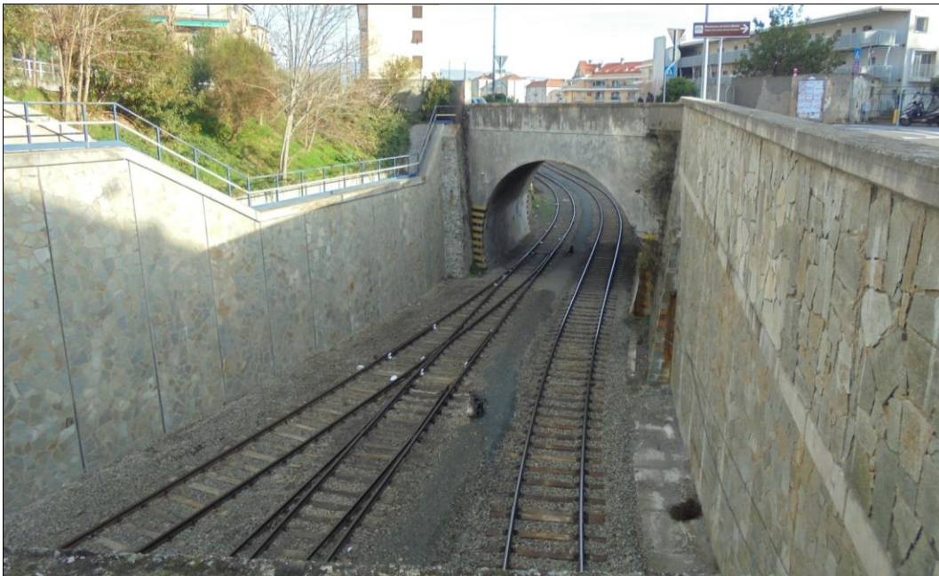
Figura 30. Panoramica della ferrovia nel segmento in trincea a ovest del centro storico
