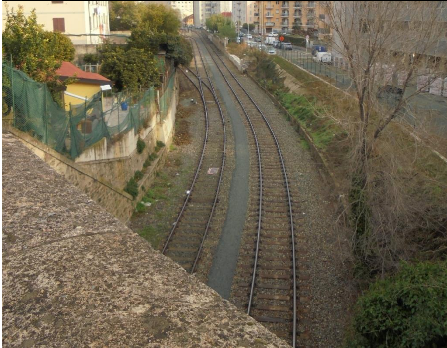
Figura 3. Panoramica dell'area meridionale dell'intervento, dal sovrappasso ferroviario di via Sabazia
