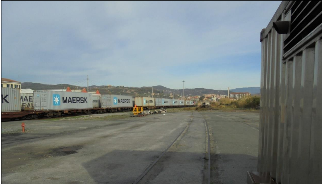
Figura 13. Particolare dell'area del piazzale dove ricadranno i fabbricati tecnologici e la vasca
