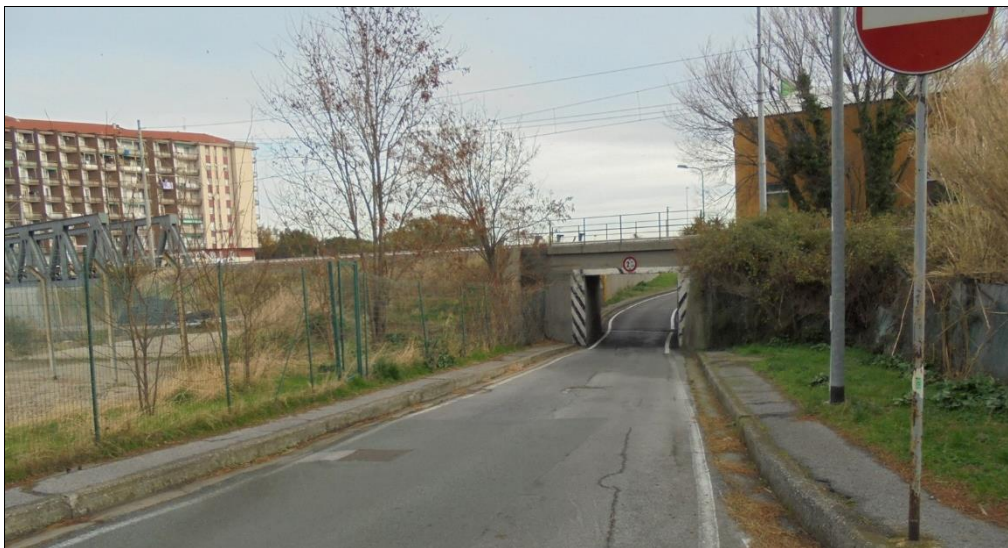
Figura 2. L'estremità settentrionale dell'area di intervento, visibile sulla sinistra il ponte sul torrente Segno
