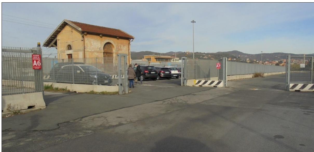
Figura 12. Panoramica dell'area di intervento
