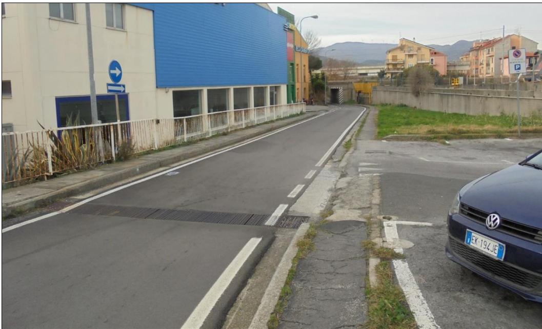
Figura 6. Via Leopardi, ramo settentrionale, tratto tra il sottovia e la via Aurelia (NV03)
