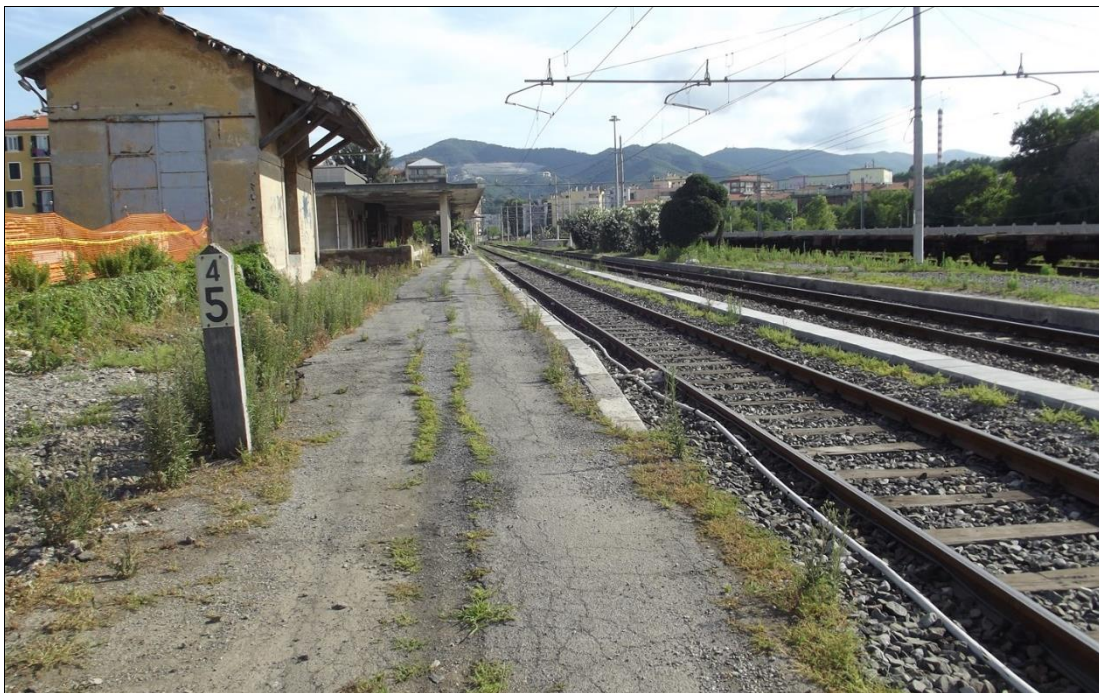
Figura 14. Area di realizzazione della nuova viabilità, a sinistra il fabbricato da demolire
