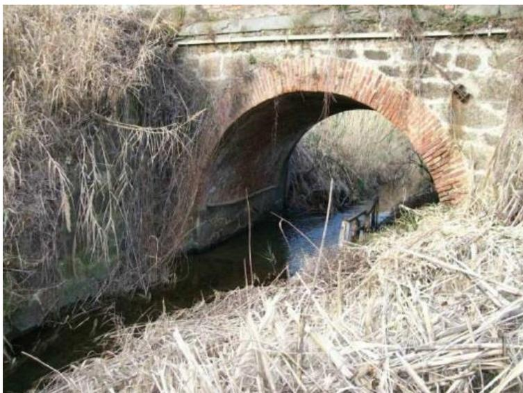
**Figura 9.1** – Ponte esistente sul Rio Lusso – Ponte ad arco in muratura
