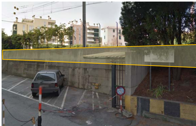
Dettaglio Demolizione Muro D16 Scuole
