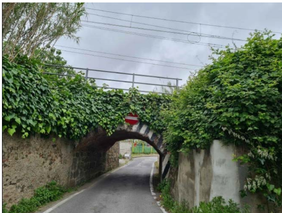
Figura 7.1 – Ponticello in muratura sottobinario
