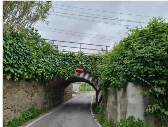
Figura 4.3 attraversamento ferroviario via Leopardi
