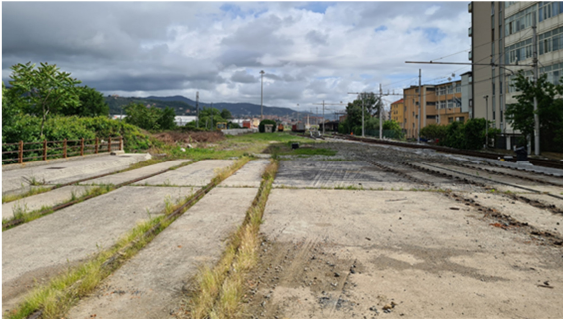
Ponte via Ferraris - Immagine dei binari esistenti
