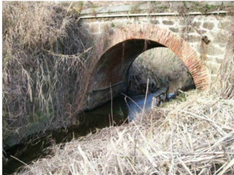
Ponte esistente sul Rio Lusso – Ponte ad arco in muratura
