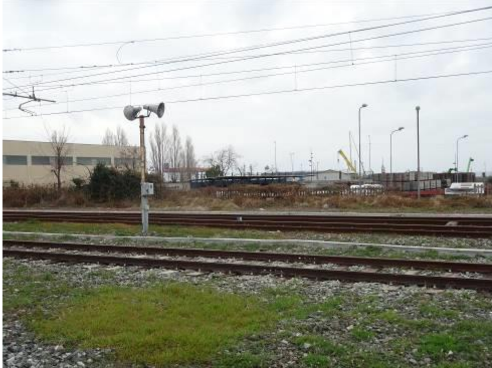
Figura 2: palina lato Est dello scalo da rimuovere, presso innesto raccordo Vernazza
