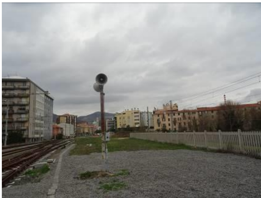
Figura 1: palina lato Ovest da rimuovere, nei pressi del deviatoio di ingresso al raccordo Alstom
