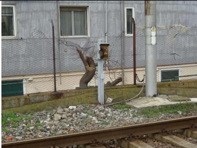
Figura 3: telefono BL da rimuovere lato Ovest inizio 1° binario
