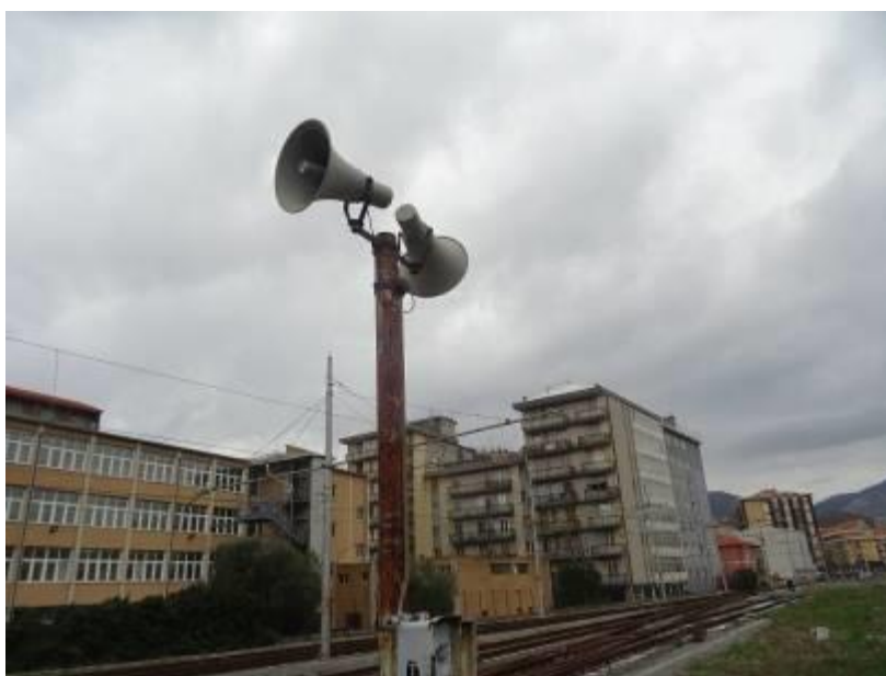
Figura 6: particolare trombe esistenti per diffusione sonora di piazzale
