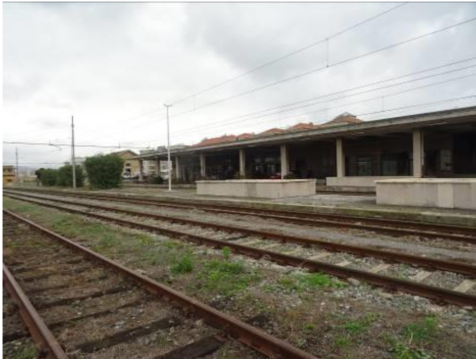
Figura 2: vista generale dell'impianto in configurazione attuale, si notano i marciapiedi e le pensiline a servizio dei binari I, II e III
