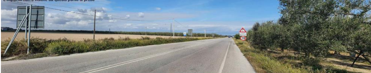
Punto di presa 2: Panoramica stato dei luoghi
