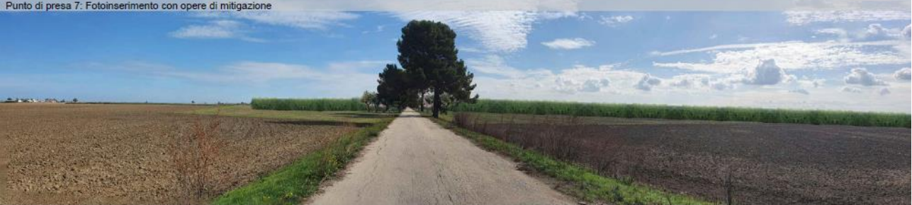
Punto di presa 8: Panoramica stato dei luoghi
