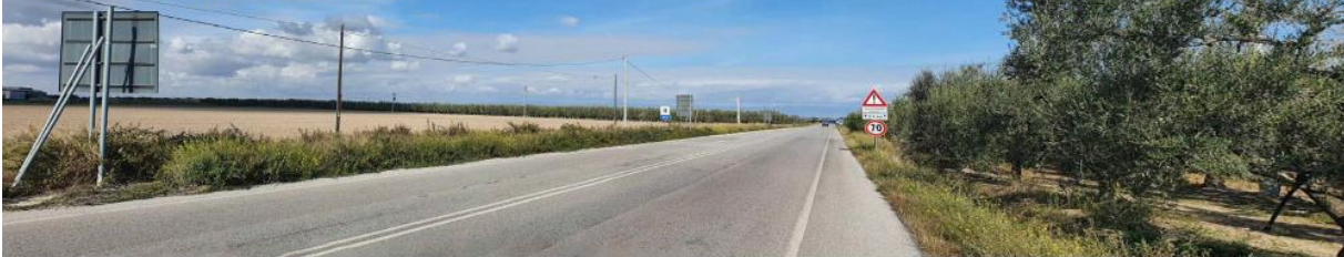
Punto di presa 2: Panoramica stato dei luoghi
