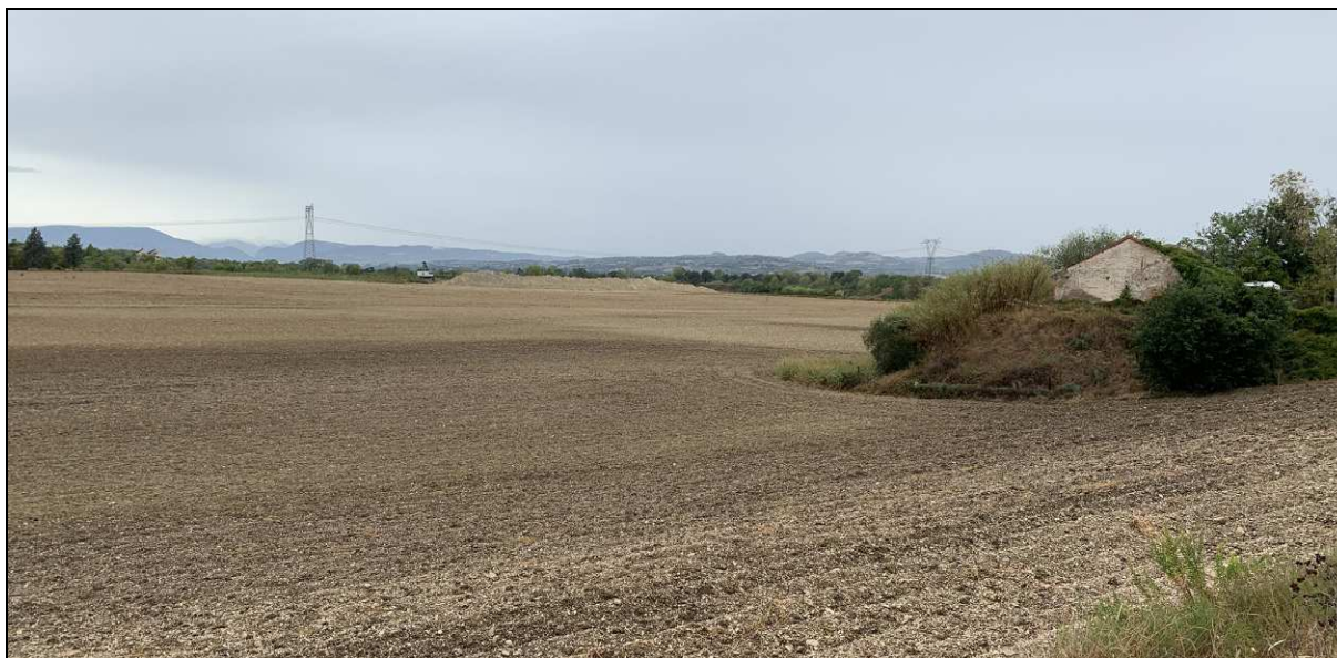
Foto n. 2 – Indicazione della linea dell'elettrodotto
