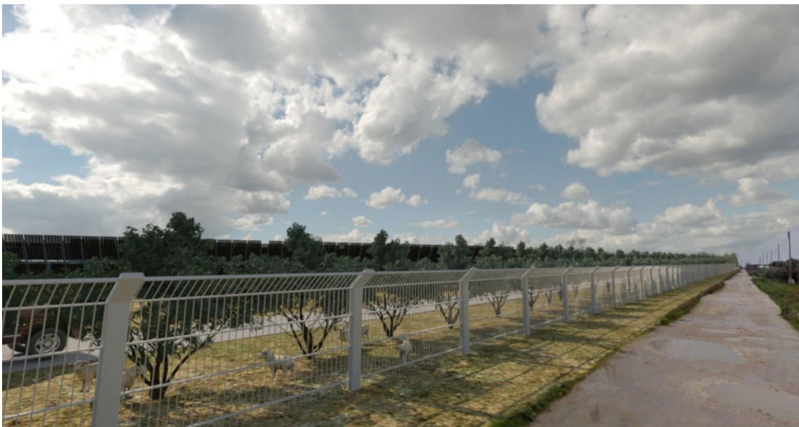
FIGURA 20 – POST-OPERAM CAMPO NORD – FRONTE STRADA COMUNALE SAMMICHELE DELLE VIGNE
