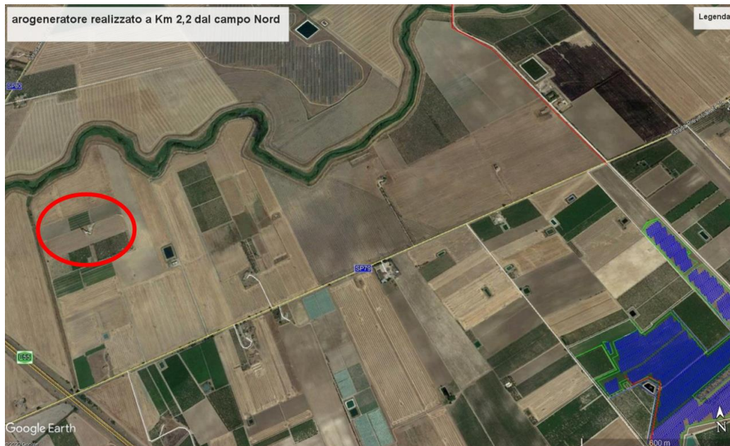
FIGURA 6 – UNICO AEROGENERATORE REALIZZATO (E/76/08) A CIRCA 2.2 KM DAL CAMPO NORD (GOOGLE EARTH – IMMAGINE DEL 07/07/2019)
