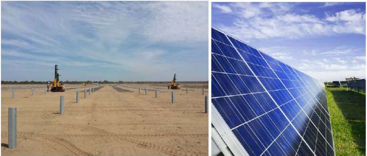
Figura 7 – Operazioni di posa delle strutture.
