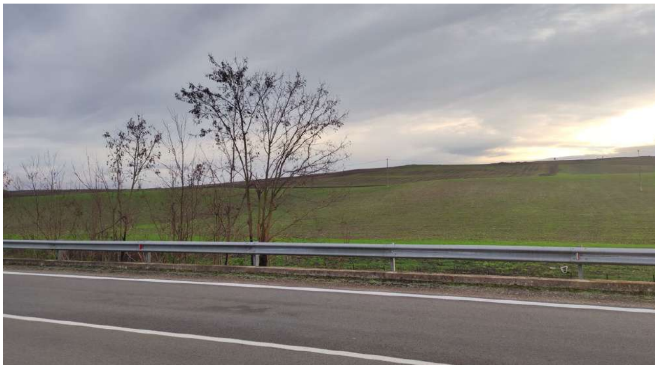
Figura 36 – Panoramica area impianto.
