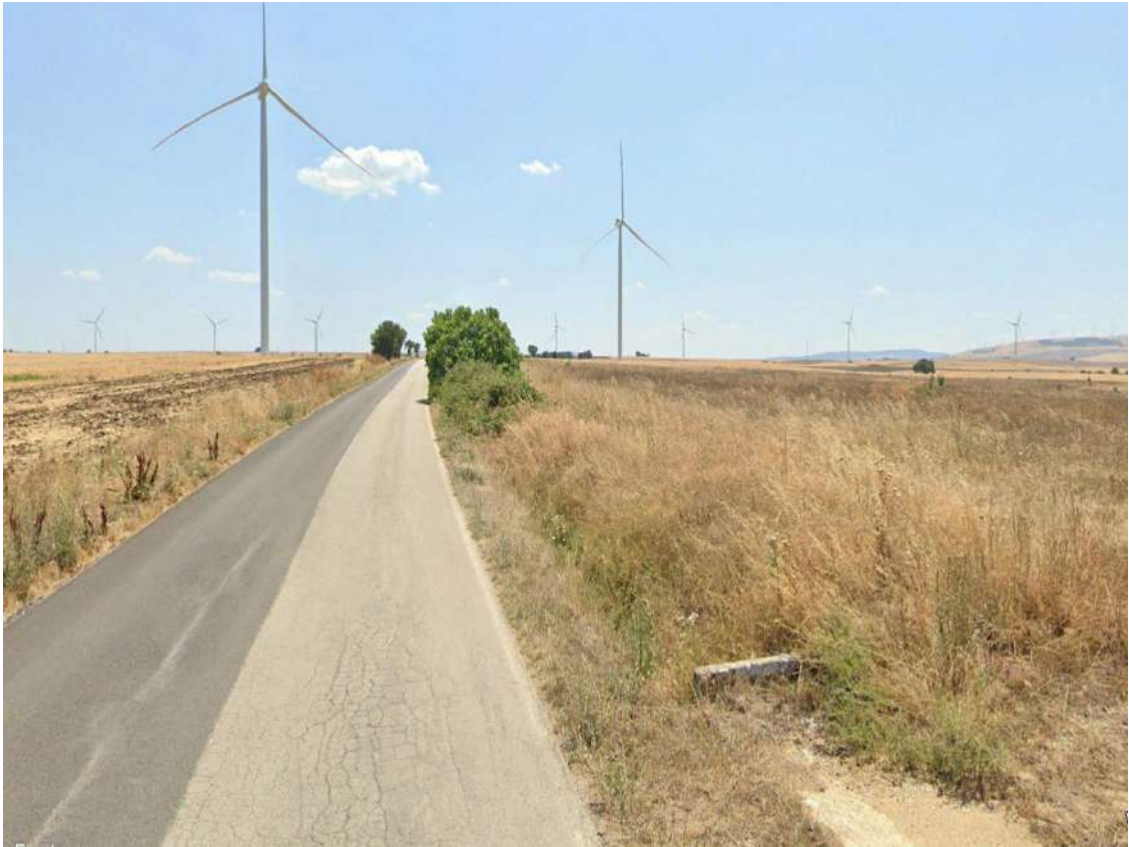
FOTO 1A – PUNTO DI PRESA N° 1 STATO DI FATTO
