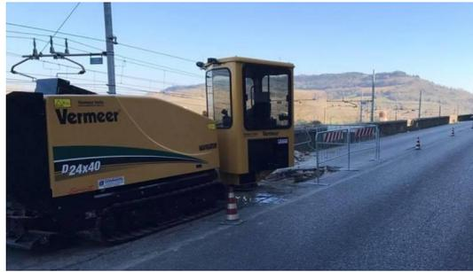
*Illustrazione 20: Tipologia macchina perforatrice per esecuzione della TOC*
